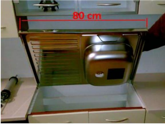
Setzen Sie das Becken von hinten auf den Schrank.
