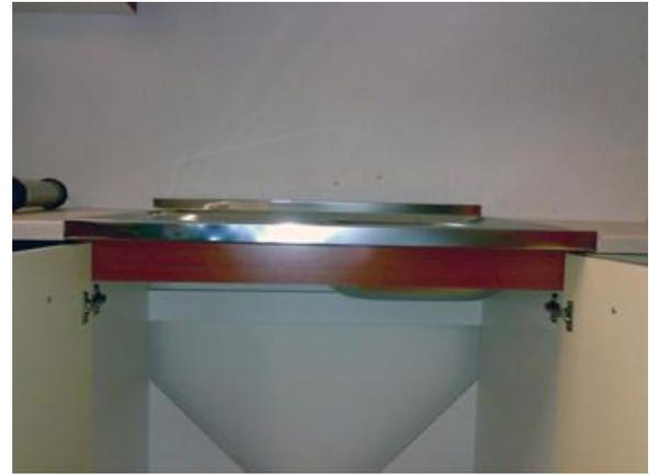
Schieben Sie das Becken **mit der Wand hinten bündig**. Vorn schließt das Becken **bündig mit der Arbeitsplatte ab**. Tragen Sie **weiteres Silikon Rechts und Links sowie im Inneren des Beckens** auf um den Spalt zwischen Becken und Arbeitsplatte wasserdicht zu machen und dem Becken weitere Stabilität zu geben.
